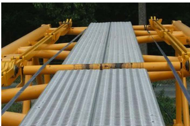
▲ Tijdelijke leeflijnconstructie op niveau van loopborden
