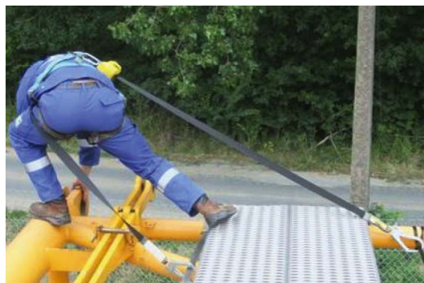
▲ Gebruik van twee-lijnen-systeem in de praktijk
