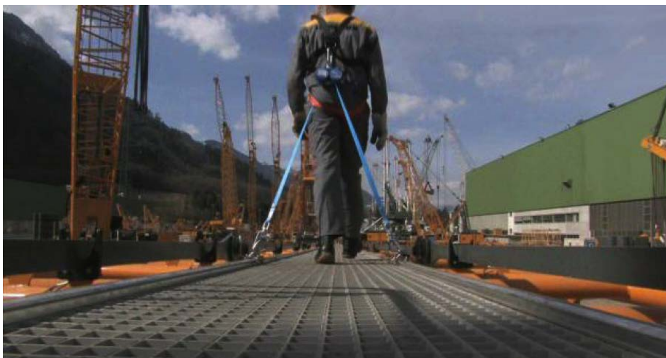
▲ Geleiderailsysteem met een twee-lijnen-systeem
