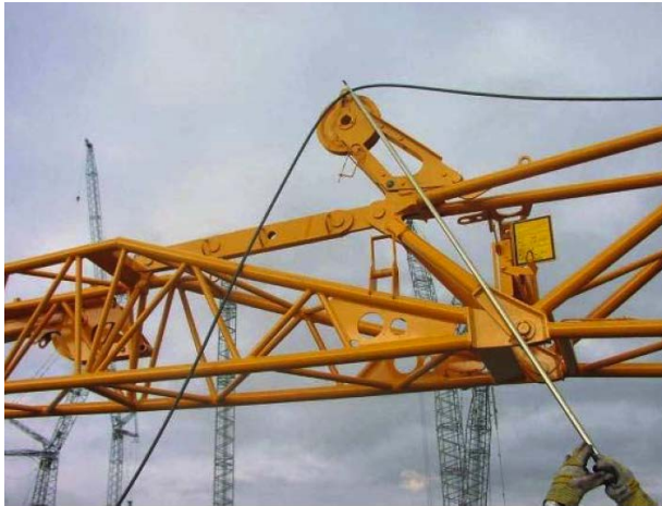
▴ Toepassing van simpele hulpmiddelen voorkomt onnodig werken op hoogte
