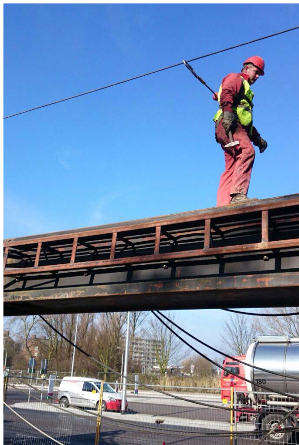
▲ Veilig aangelijnd op de makelaar middels een tijdelijke leeflijnconstructie
