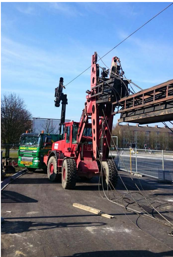
▲ Spannen tijdelijke leeflijn met behulp van bijvoorbeeld een autolaadkraan. Voorkom doorhangen en beperk zoveel mogelijk de lengte van de leeflijn om schijnveiligheid te voorkomen
