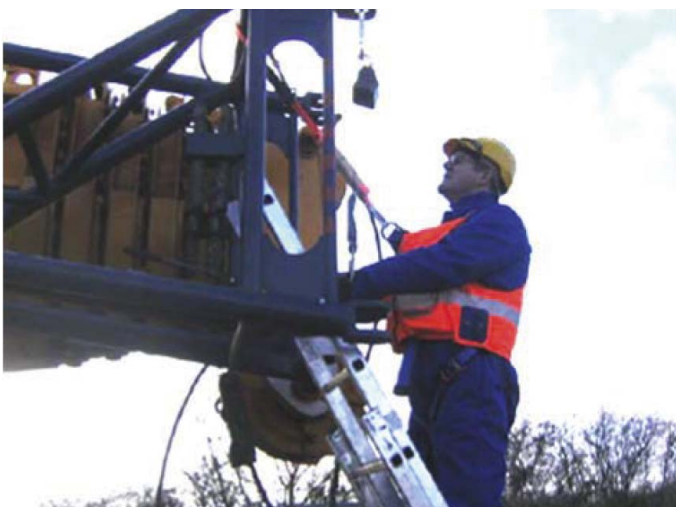
▴ Toepassen van harnassen met een vaste lijn t.b.v. onderhouds-, reparatie- en aftankwerkzaamheden
