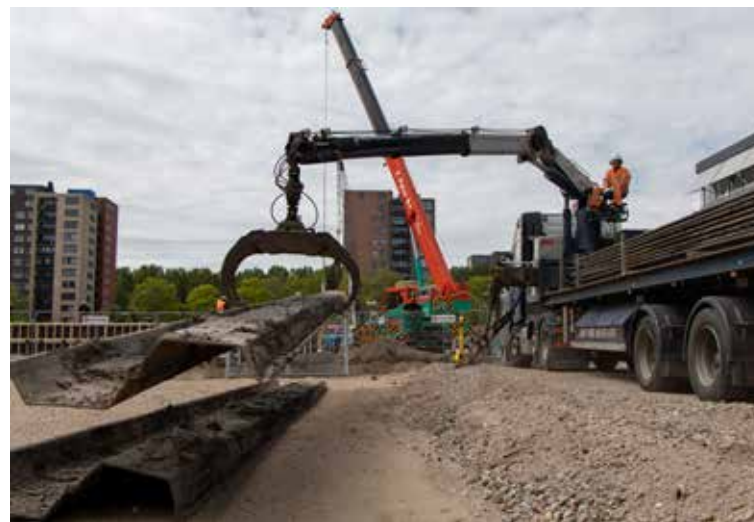
Damwandgrijper op autolaadkraan (ALK)
