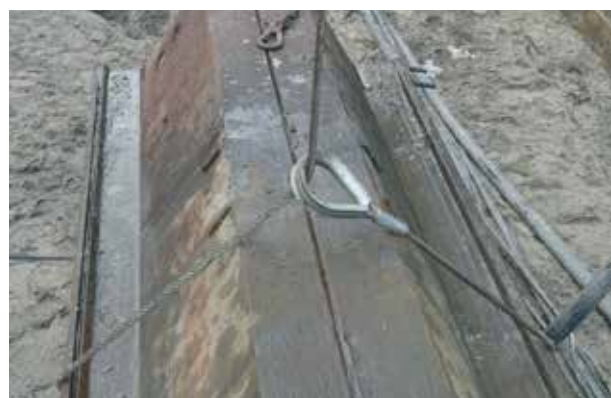
Rijgstrop met kabelkous
