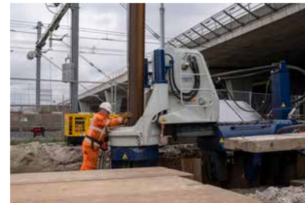
Drukken van enkele planken met een Silent Piler
