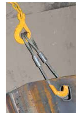
Correct aangeslagen damwand
