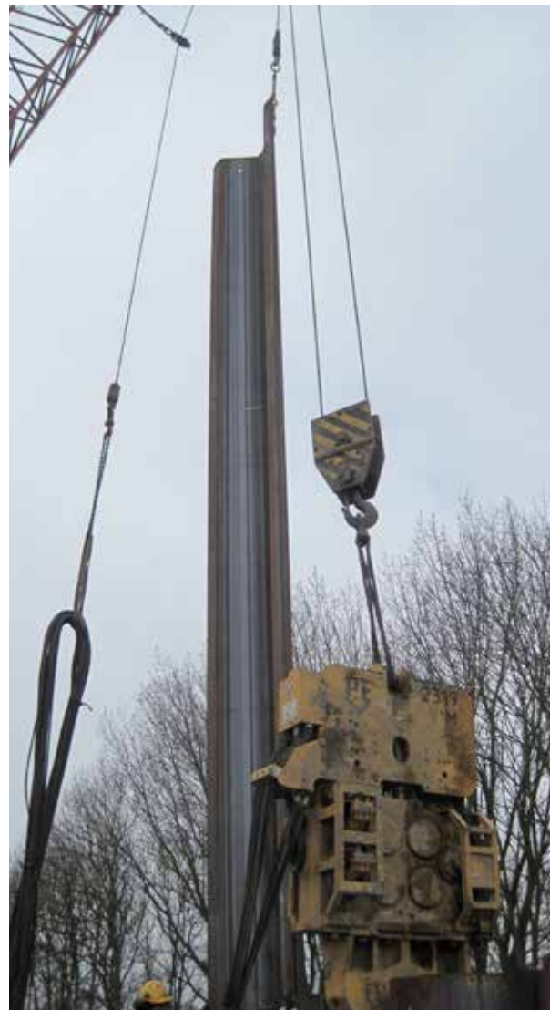
Trilblok en hijsen damwandplank
