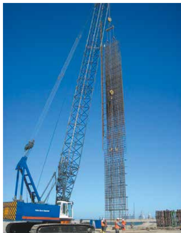
Aanbrengproces diepwanden
