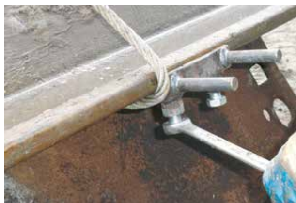
Slotklem tegen afschuiven
