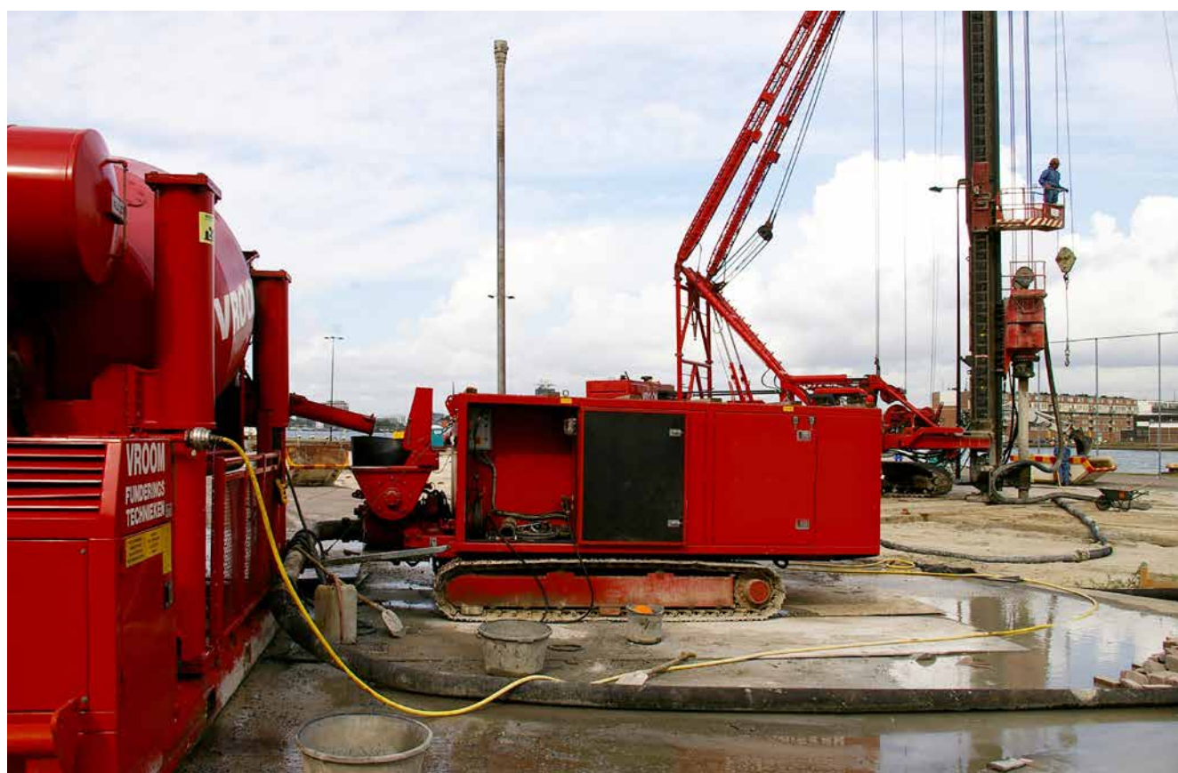
Het verpompen van beton.
